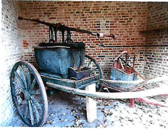
Voilà à quoi ressemblait une pompe à incendie
